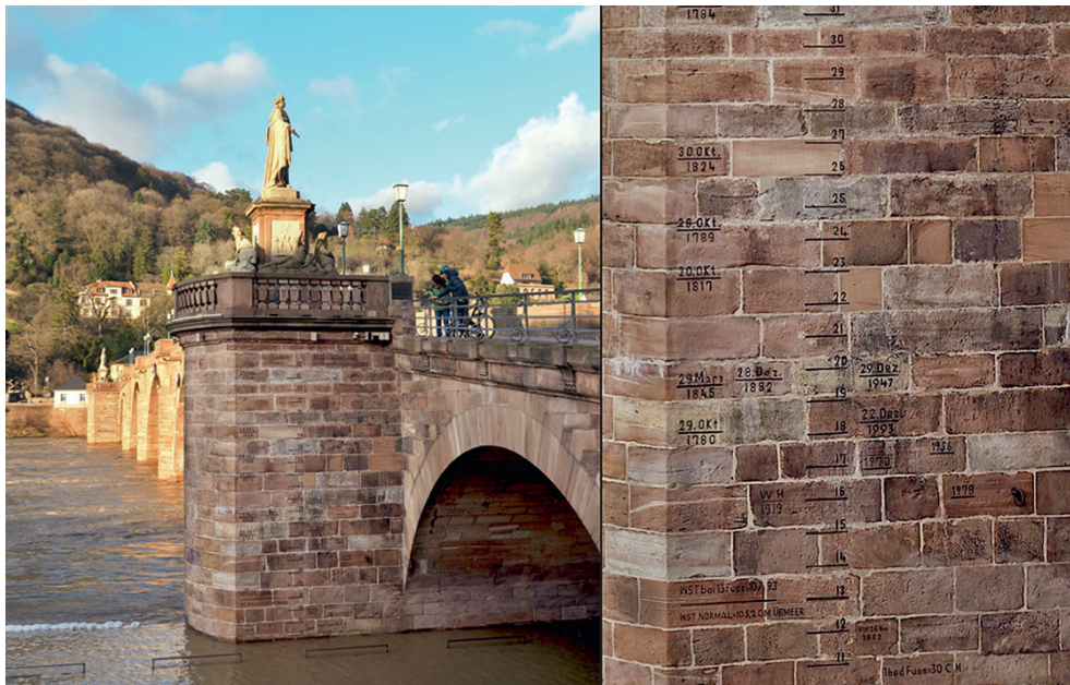
Abb. 1: Die „Alte Brücke“ über den Neckar in Heidelberg. Am südwestlichen Brückenpfeiler befinden sich die Hochwassermarken der letzten Jahrhunderte (rechts). Die Brücke wurde am 27. Februar 1784 durch ein katastrophales Eishochwasser zerstört. Dieses Hochwasser folgte einem besonders kalten und schneereichen Winter in Nord- und Mitteleuropa, der durch die Laki-Spalteneruption auf Island im Jahr 1783 verursacht wurde. Das Hochwasser von 1784 ist das bislang höchste, welches am Neckar gemessen wurde. Copyright: Das Foto wurde freundlicherweise von Janet Harvey aufgenommen und zur Verfügung gestellt.
